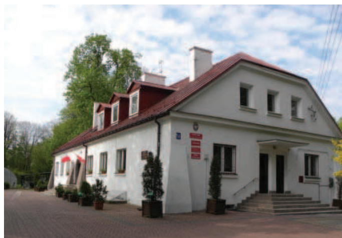
Ilustracja 4. Budynek dworu – elewacja północna, fot. M. Dudkiewicz (2012).
