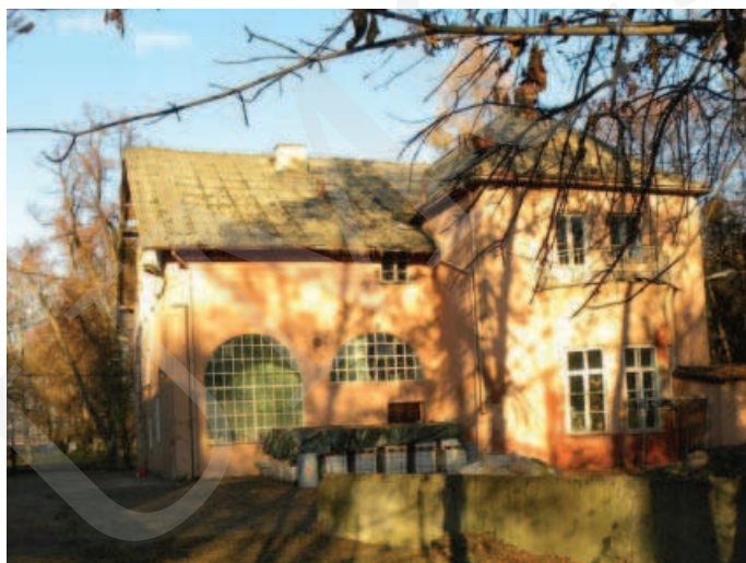
Ilustracja 3. Budynek pałacu – elewacja południowa, fot. M. Dudkiewicz (2012).
